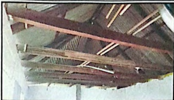
Foto 1: la madera en mal estado por la polilla
