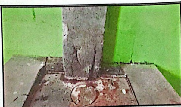
Foto 9: chimenea agrietada
